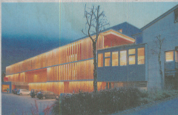
Aus Holz und energieautark: In seinem Betriebsgebäude hat Walter Meiberger seine Vorstellungen konsequent umgesetzt.
